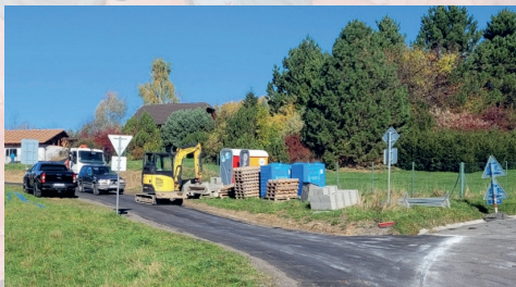
opravena cesta na Odmiarek
